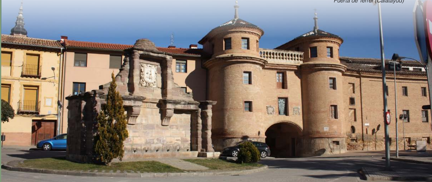
Puerta de Terrer (Calatayud)
